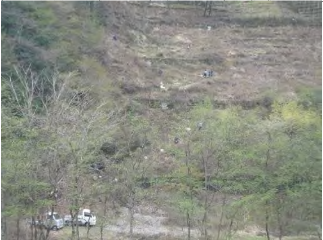
説明 対岸の急斜面への資材運搬
